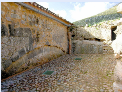
Reconstrucció de la coberta dels graners i obertura dels forats per on s'aboca l'oliva
