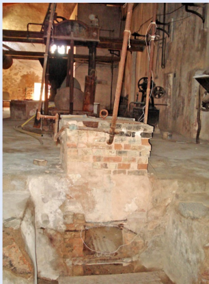
Restauració de la fornal i de la xarxa de canalització de l'aigua
