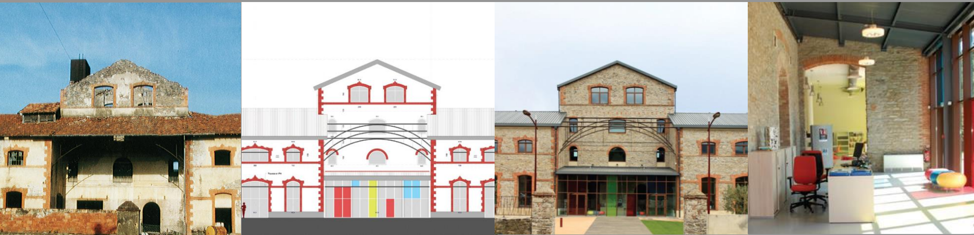
Ancienne usine à tanin de Folelli, réhabilitée en 2012-2014 pour devenir la médiathèque de la Castagniccia
